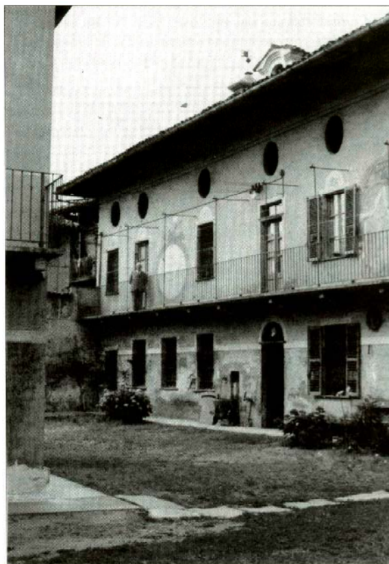
Palazzo Rogliardi - Pradotto, facciata sul cortile interno
